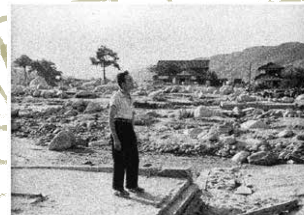
土石流の被災箇所で呆然と立ち尽くす住民 (旧山梨県武川村牧の原地区)
